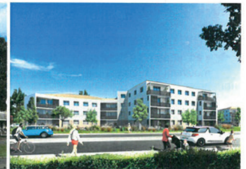
Photo après requalification
