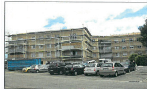
Photos du chantier
